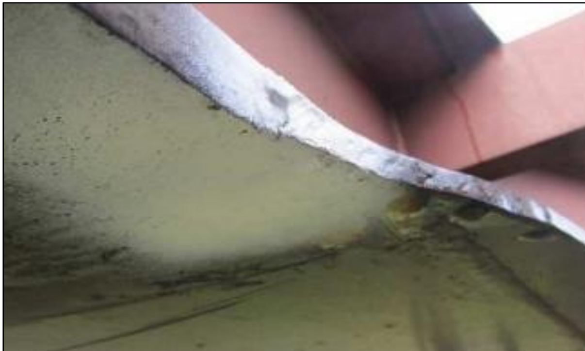
14. att. Stūra plātnes pievienojuma plauktam zona, kas izpildīta ar laidenu pāreju uz platformas Nr. 94962040
