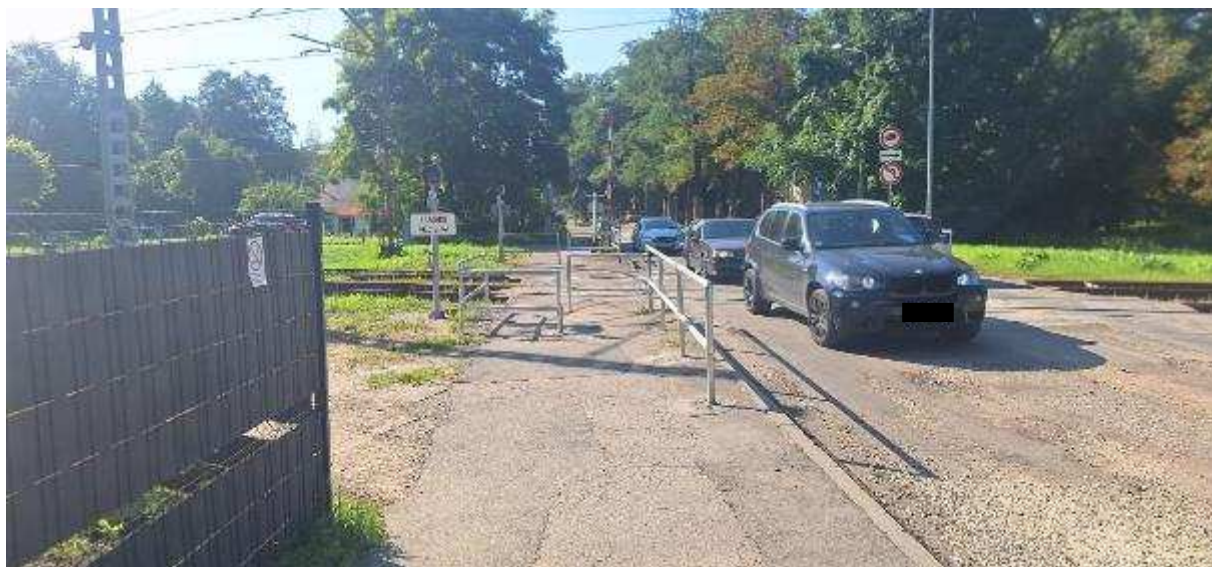
14. att. Pēc negadījuma uzstādītais gājēju kustības regulējošais norobežojums. Skats no Akāciju ielas puses
